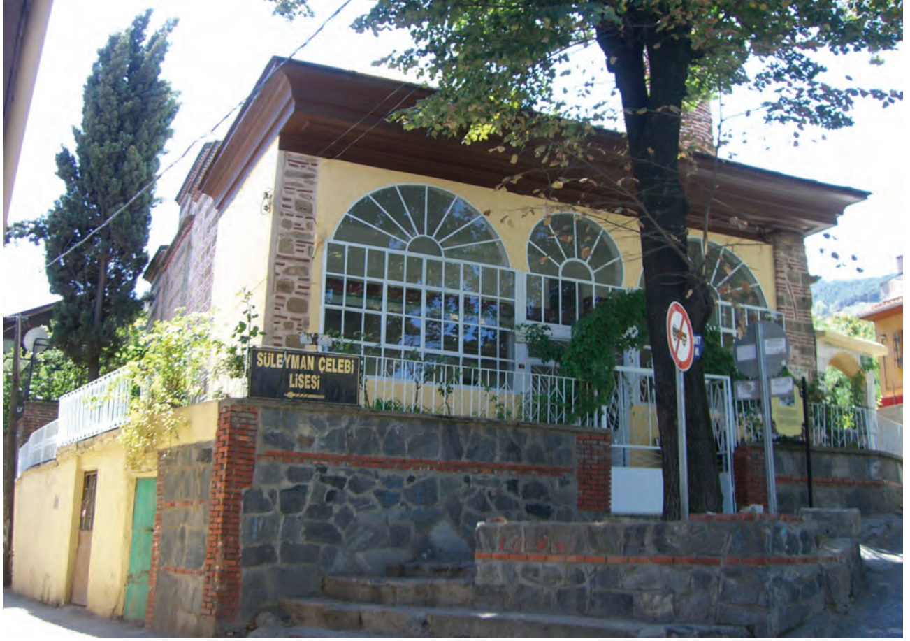
Bursa Veled-i Vezir Cami ön cephesi
