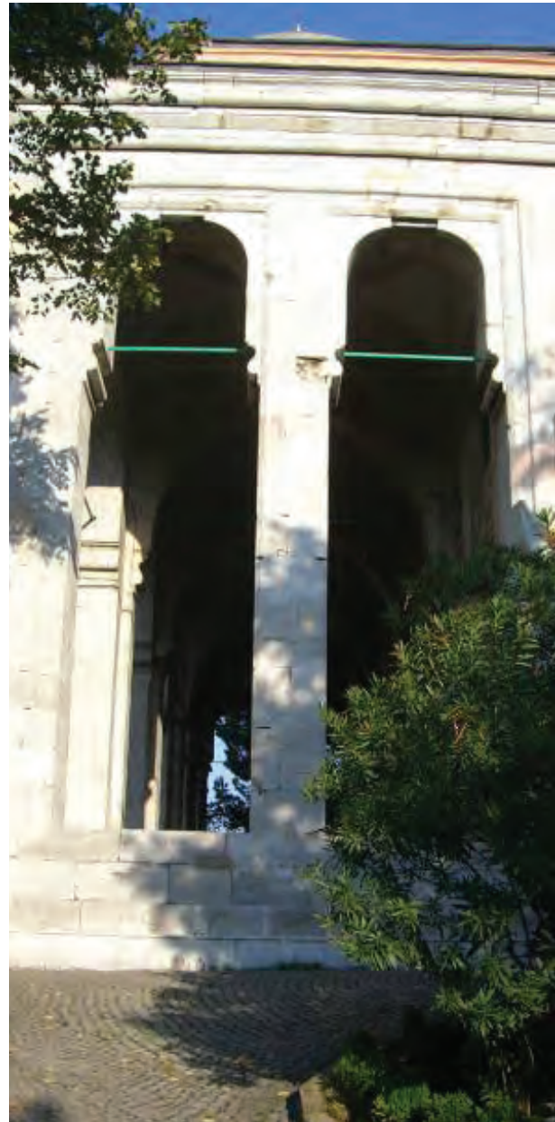
Bursa Yıldırım Camii, revak yan cephe
