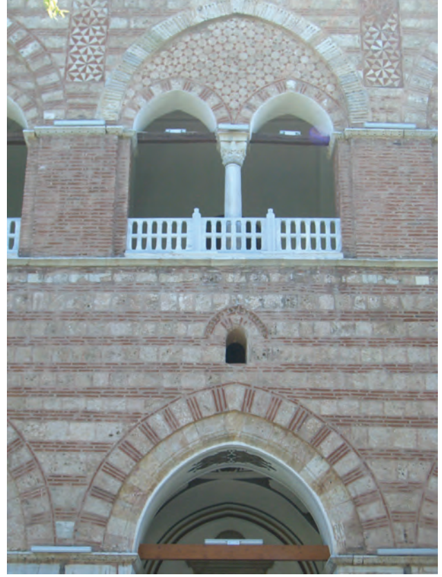
Hüdevendigar Cami cephe detayı
