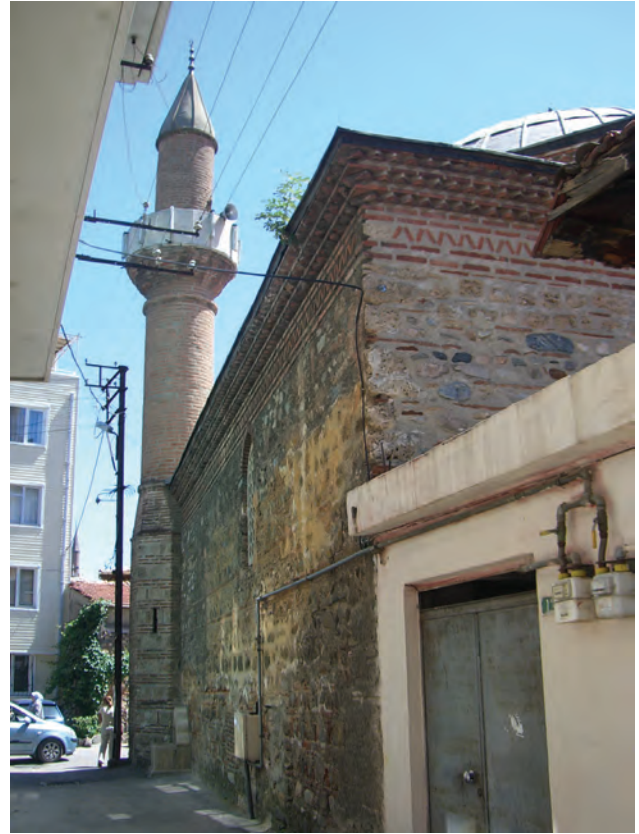
Bursa Yerkapı Cami yan görünüşü
