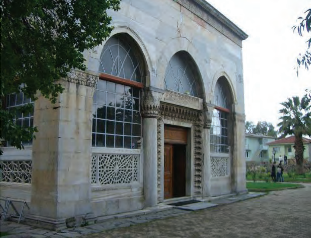
İznik Yeşil Cami ön cephesi
