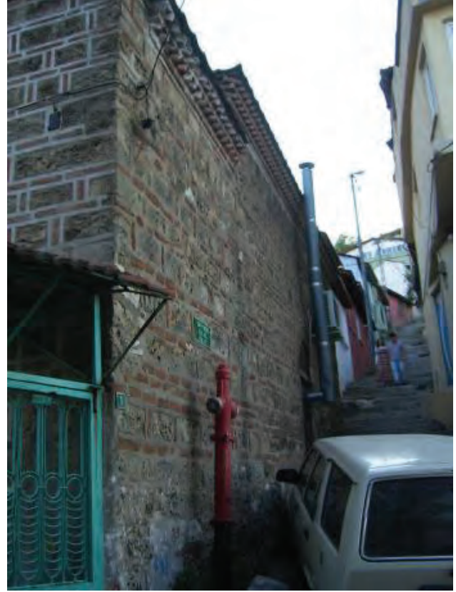
Bursa Hıdırlık Cami duvar detayı
