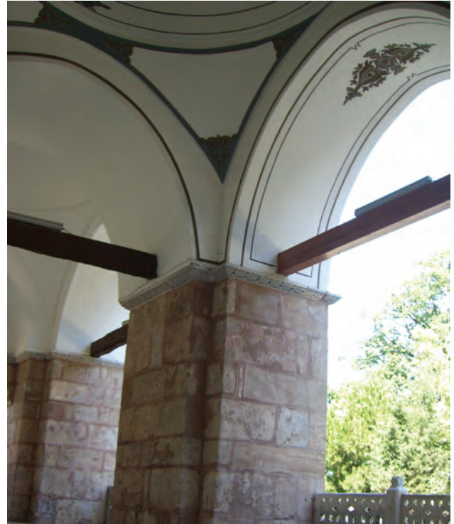
Bursa Hüdavendigâr Cami revak taşıyıcı ayakları
