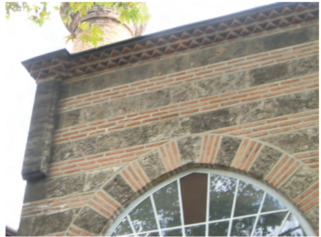
Ebu İshak Cami kalkan duvarı üst köşe detayı
