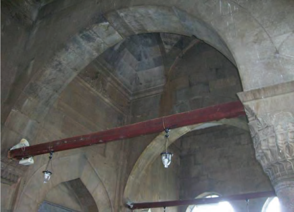
İznik Yeşil Cami revak iç kemerleri- gergi detayı
