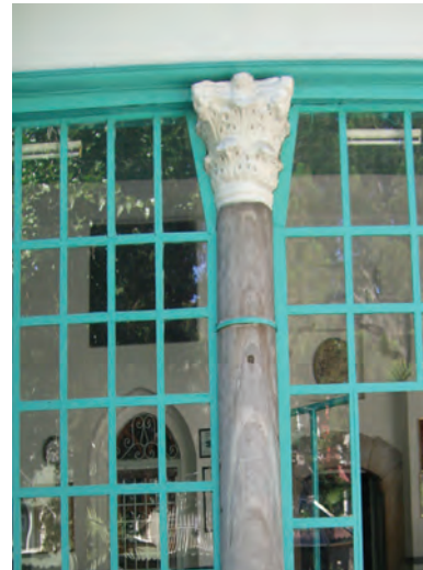
Revak taşıyıcı sütunu
