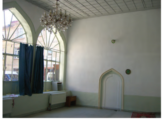
Bursa Yerkapı Cami orijinalliğini kaybetmiş revak iç görünümü
