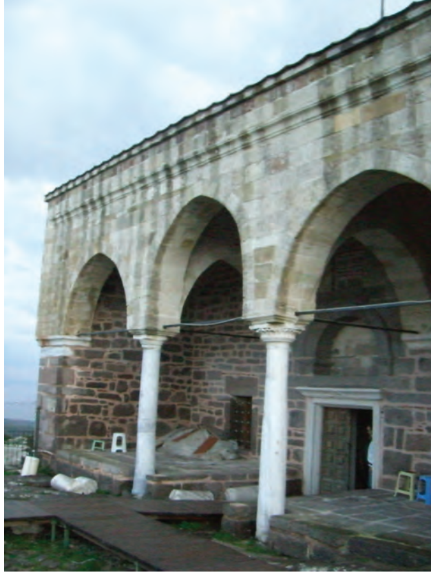
Behramkale Hüdayendigar Cami giriş cephesi
