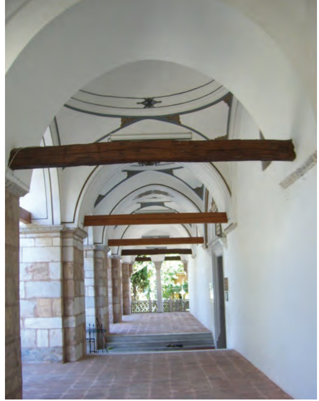
Bursa Hüdavendigâr Cami ahşap gergi detayı
