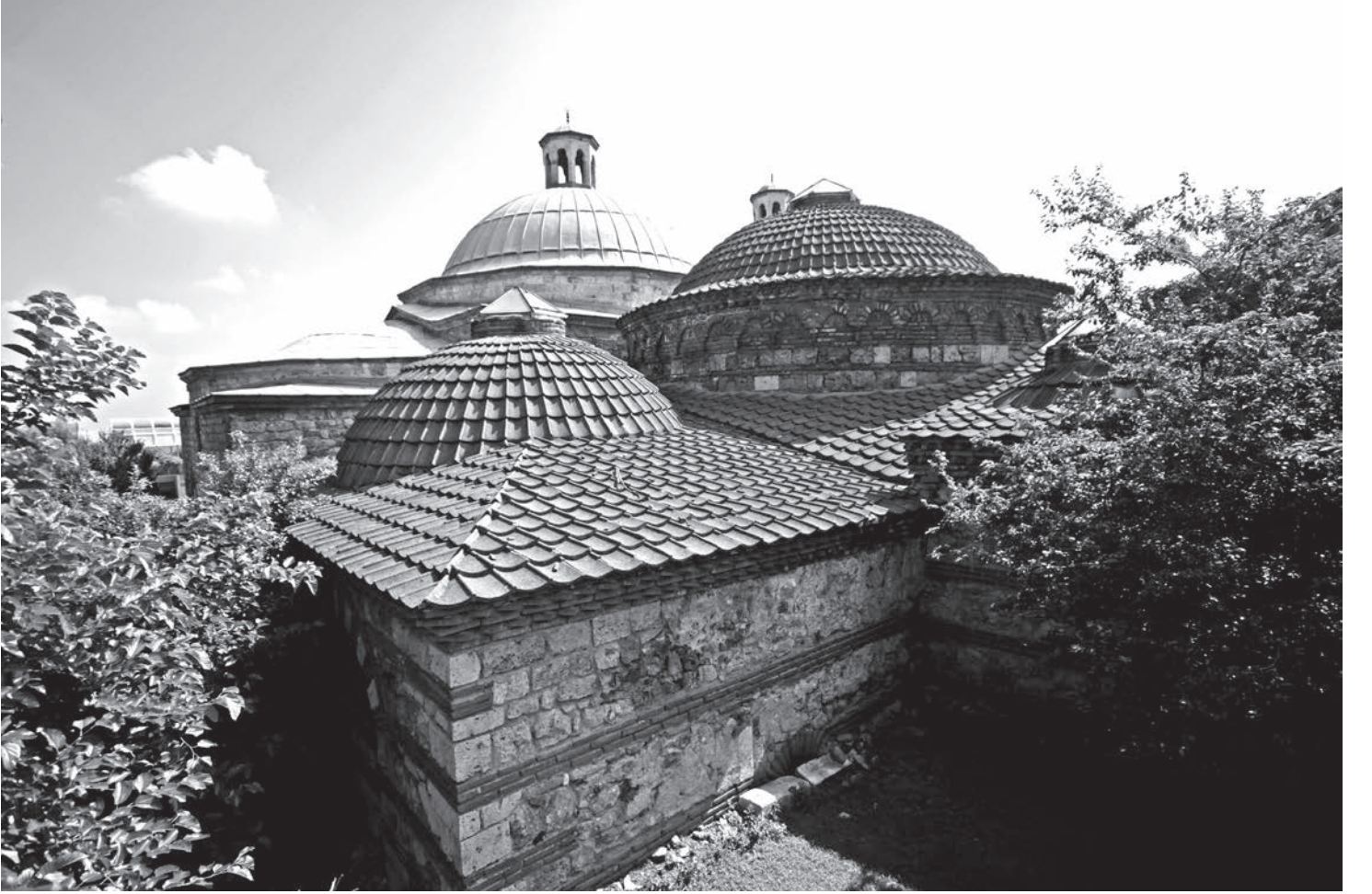
Eski Kaplica Ft. Hakan Aydın
